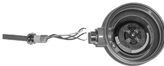
Abb. 3-8: Installation der Kabelverschraubung
