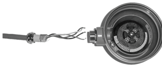
Figura 3-8: Instalando o corpo da vedação
