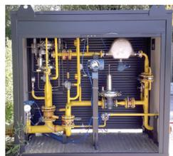
Injectez du GNL regazéifié dans le réseau de gaz naturel avec des stations de réduction de pression et de comptage.
